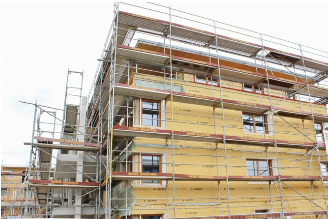
Wohnen im Holzbau: Brettsperrholzkonstruktion mit GUTEX Thermowall WDVS. Foto: GUTEX
