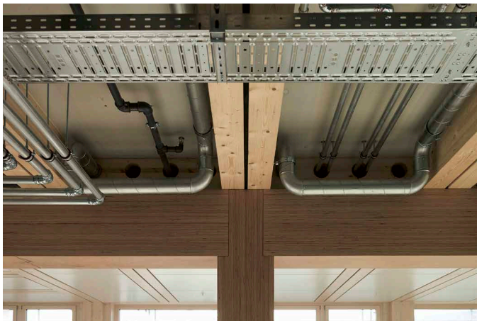
Deckenintegrierte Installationsebene mit „BauBuchen“-Tragwerk.
