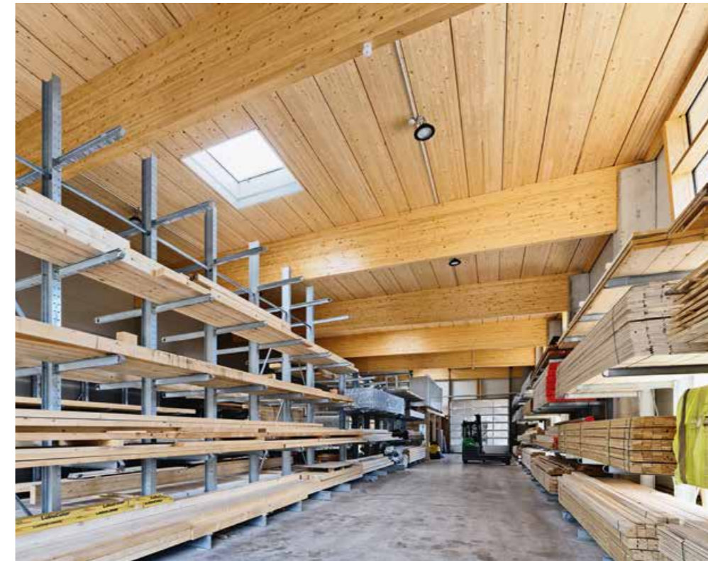
▲ Rund 580 m 2 der neuen Halle nimmt der Lagerbereich in Anspruch
