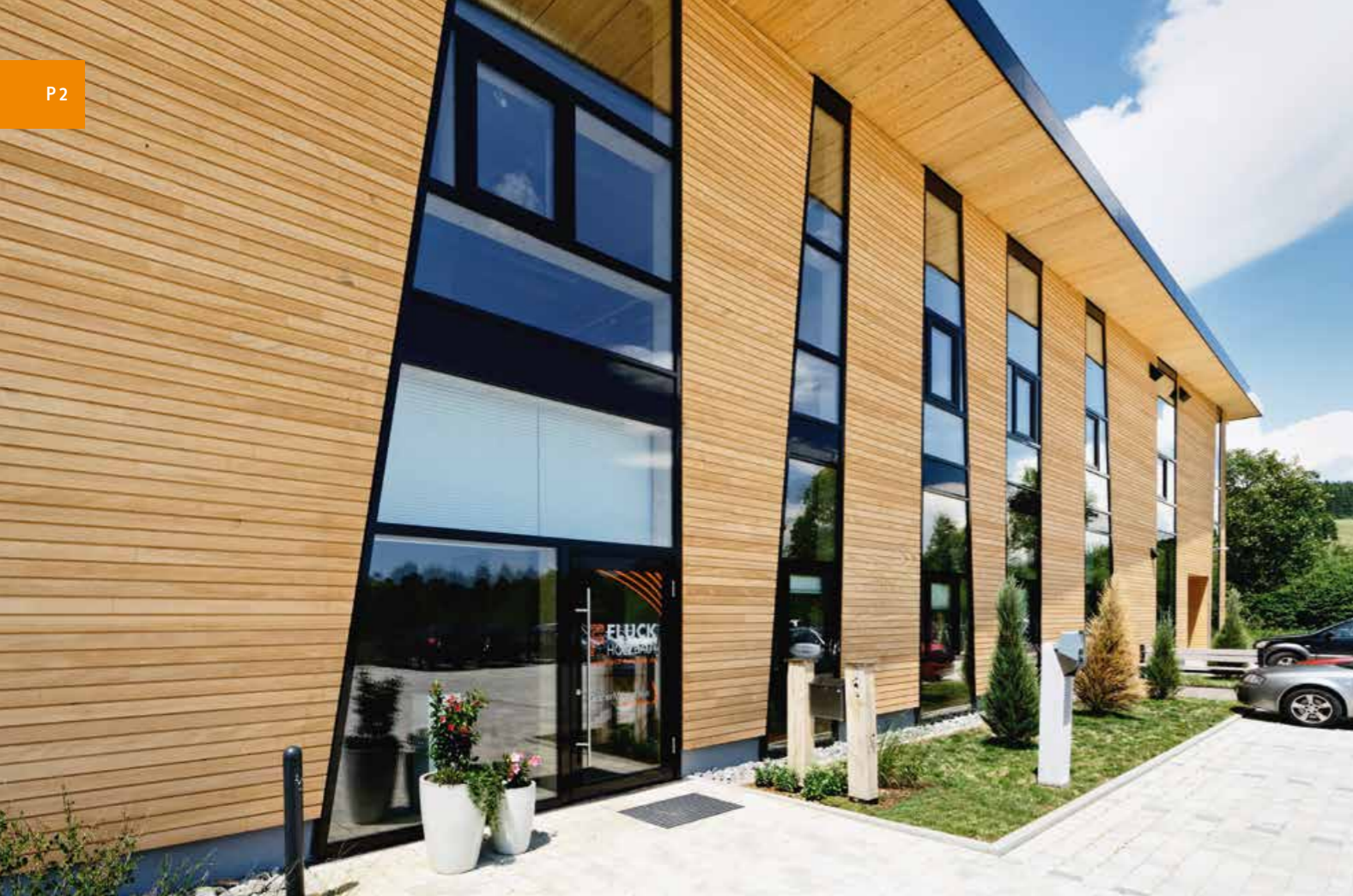
▲ Die Fassade im Bereich der Verwaltung erhielt eine waagerechte, geölte Weißtannenschalung
