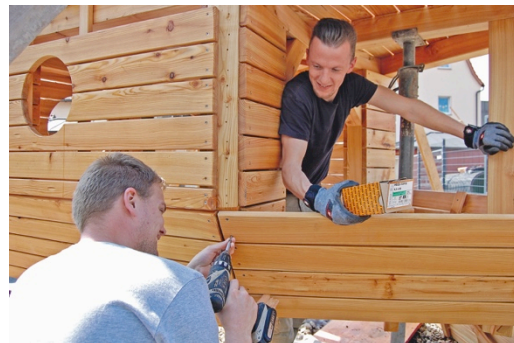
HECO_Kinderwelt_Waldaschaff_02.jpg Bepankung des Schiffsbugs unter Einsatz der HECO-TOPIX Edelstahlschrauben. (Bild: Jens Möhrlein)
