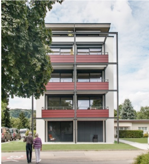
5-Geschossiger Holzbau mit Holzfaserdämmung in Lörrach, Geb.Kl. 4, Erdbebenzone 3, Aufrichtzeit 9 Tage (Bild: Lignotrend)
