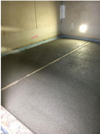
Holzbalkendecke mit Splittschüttung und SWISS KRONO OSB-Belplankung (Fotos: Wolf Bavaria GmbH)
