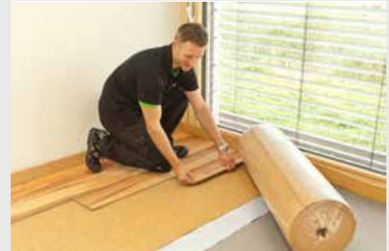
Rollbare Trittschalldämmung: durch stehende Holzfasern sind die neuen Holzfasermatten besonders druckfest.
