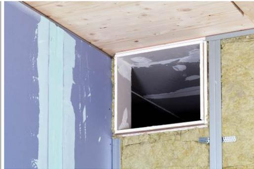
Keine Wand wie die Andere: So bestehen die Brandwände an den Stellen, an denen etwa Brandschutzklappen eingebaut werden müssen, aus 120 mm Brettsperrholz, das mit 2 x 18 mm GKF-Platten, 40 mm Mineralwolle und CW 50 Doppelständerwerk sowie zwei Lagen mit je 20 mm GKF-Platten beplankt wurde.
