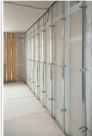
Die Tragstruktur der neuen Wohnheime für Anwärter der Bereitschaftspolizei besteht aus Brettsperrholz. Aus Brand- beziehungsweise Schallschutzgründen die Zimmerwände jedoch mit Gipsplatten gekapselt bzw. bekleidet.
