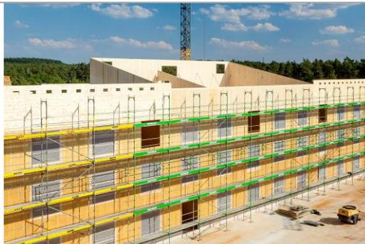
10 cm dicke fünfschichtige Brettsperrholzwände, die in Längen zwischen 7 und 12 m produziert, angeliefert und Element für Element verbaut wurden, stellen das tragende Gerüst der neuen Wohnheime. Auch die 2,75 m breiten und bis zu 12 m langen, siebenlagigen Deckenelemente aus Brettsperrholz wurden vorproduziert und auf der Baustelle zusammengesetzt. (Foto: Knauf/Stefan Ernst)
