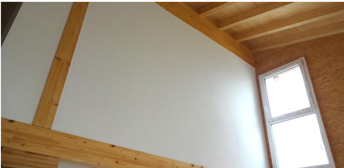
Mit Putz beschichtete SWISS KRONO MAGNUMBOARD® OSB-Oberfläche (Foto: SWISS KRONO GmbH)
