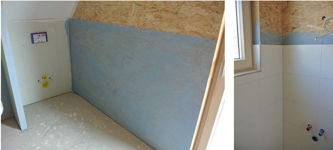
Direktbeschichtung mit Fliesen (Foto: BALAZS Komforthaus GmbH)
