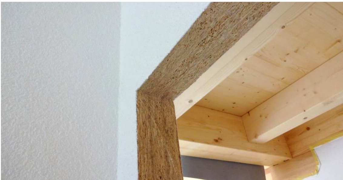
Direktbeschichtung mit Innenputz (Foto: SWISS KRONO GmbH)
