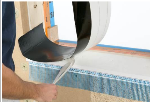
Einfache Verarbeitung: Die selbstklebende Fenster-Dichtbahn wird auf dem Dämmkeil, mit vorher angebrachter Gewebeleiste befestigt. (Foto: Knauf)
