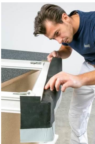
Passgenauer und dichter Anschluss: Die Fenster-Dichtecke und die Fenster-Anschlussbahn werden bereits auf der Fensterinnenseite angebracht. (Foto: Knauf)
