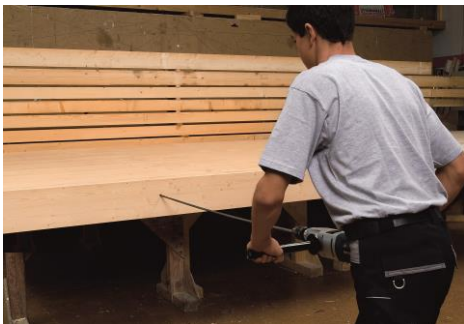
Dach+Holz 2018_HECO-WB.jpg Die Querzugverstärkung erfolgt mit den Gewindestangen HECO-WB ohne die zeitintensive Verwendung von Klebstoff. (Bild: HECO-Schrauben)
