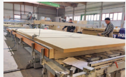
Handlung der neuen XXL-Platten in der Montagehalle
