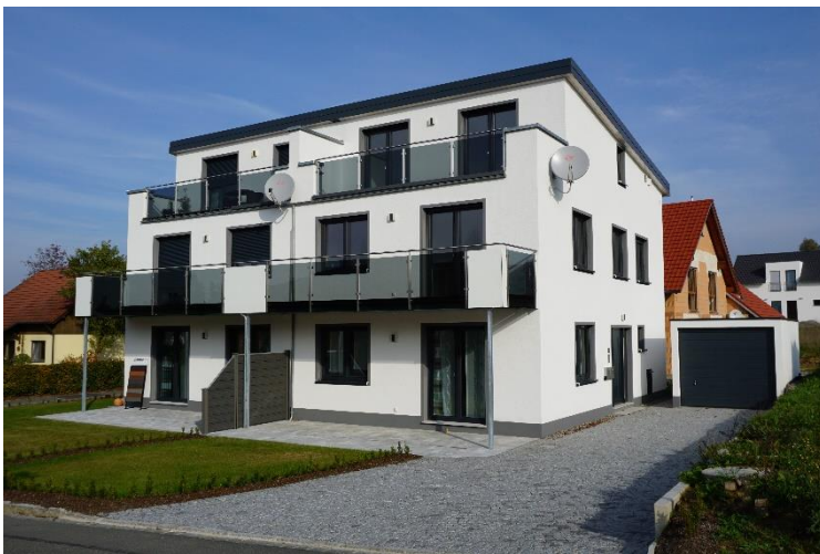
Abbildung 1: Ansicht von außen
