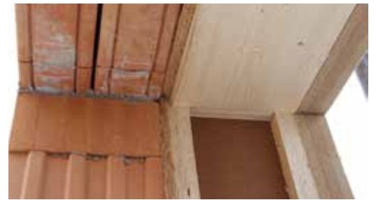
Komplette Wandkonstruktion in Hybridausführung. Die Dämmschale mit Stegträgern ist exakt auf das Rohbaumaß des Ziegelbaus abgestimmt.
