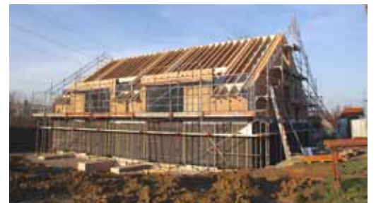
Gebäudehülle aus Holz: Fertig angebrachte Fassadenelemente und die Dachkonstruktion aus STEICO Stegträgern.
