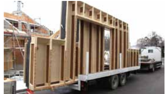
Die einseitig beplankten Elemente - besonders leicht dank STEICOjoist.
