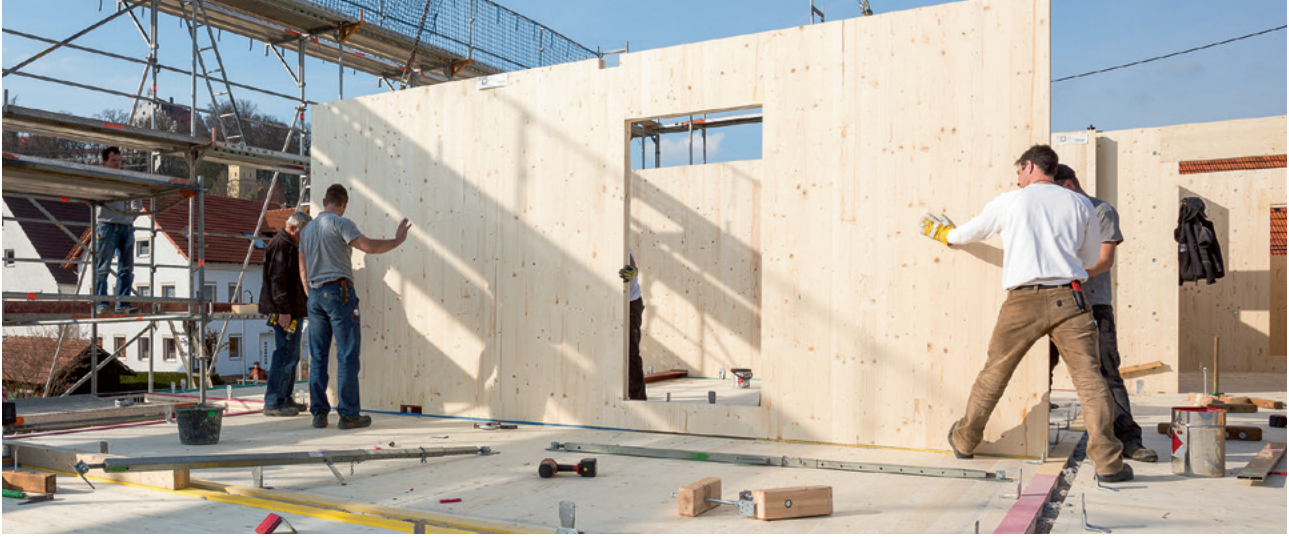
Unscheinbar, aber innovativ effektiv verhindert „GePi connect“ die Schallübertragung über die Flanken der Brettsper Holz-Elemente
