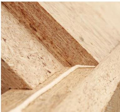
Luftdichte Abdichtung von MAGNUMBOARD® OSB Bauteilen © BALAZS Komforthaus GmbH
