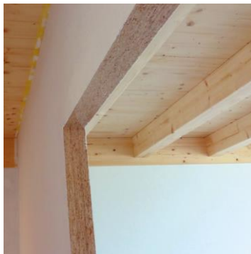
Direkte Innenbeschichtung auf MAGNUMBOARD® OSB Wänden © SWISS KRONO GmbH
