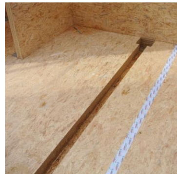
Individuelle Detaillösungen und Vorfertigung ohne Raster © BALAZS Komforthaus GmbH
