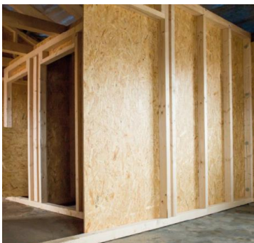
Holzrahmenbau mit SWISS KRONO OSB ©SWISS KRONO GmbH/corax GmbH
