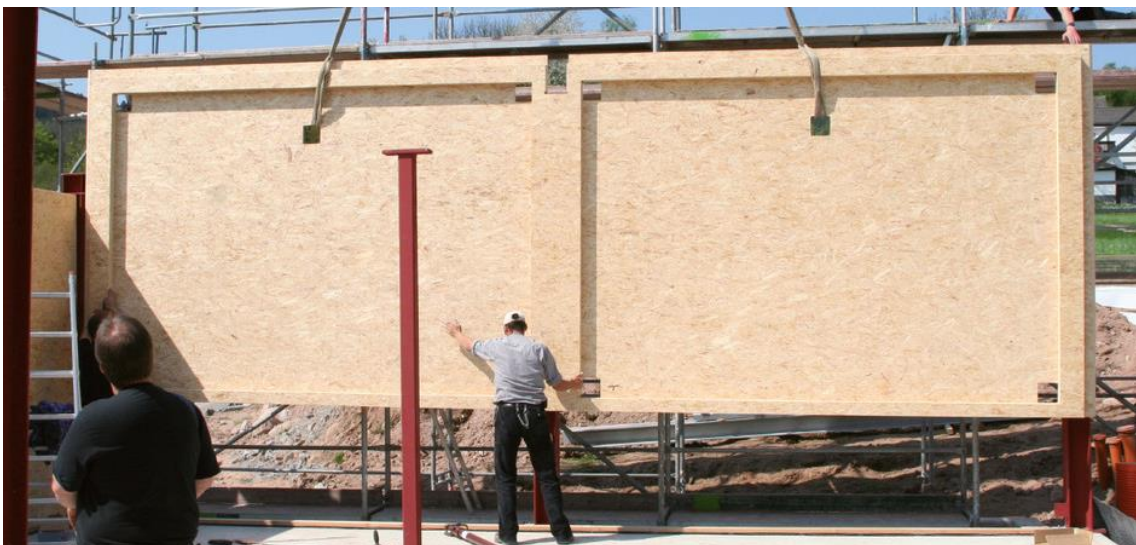
Montage von großformatigen, vorgefertigten Elementen (Foto: BEMA)
