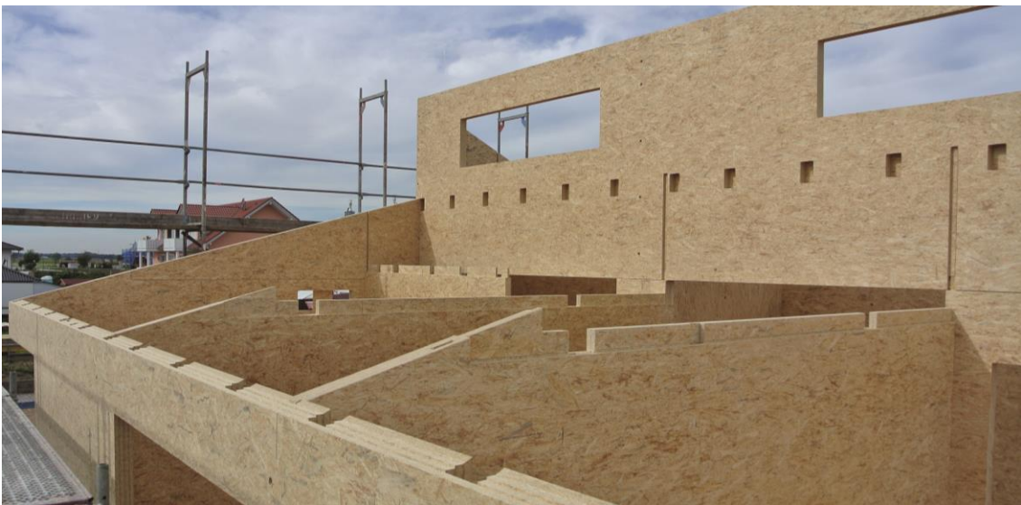
Hoher Vorfertigungsgrad beschleunigt den Bauprozess (Foto: BALAZS Komforthaus GmbH)
