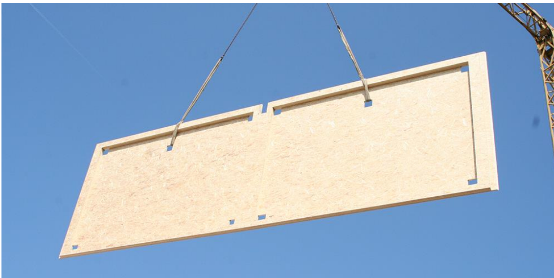
Per Kran werden die Elemente an die richtige Position gebracht (Foto: SWISS KRONO)
