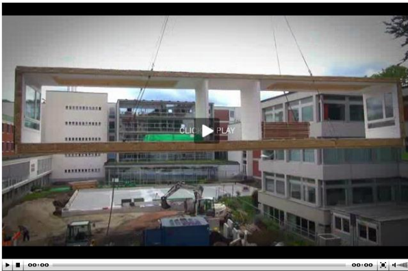
Die Produktion der ersten SWISS KRONO OSB Longboards , ihr Transport in die Schweiz, dort stattgefundene Vorfertigung und der Aufbau der Module in Nürnberg ( zum Video )
