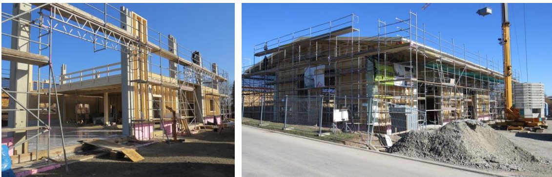
Hier entsteht die neue Zimmereihalle (Copyright: Holzbau Benjamin Roller | Fotos: SWISS KRONO GmbH)
