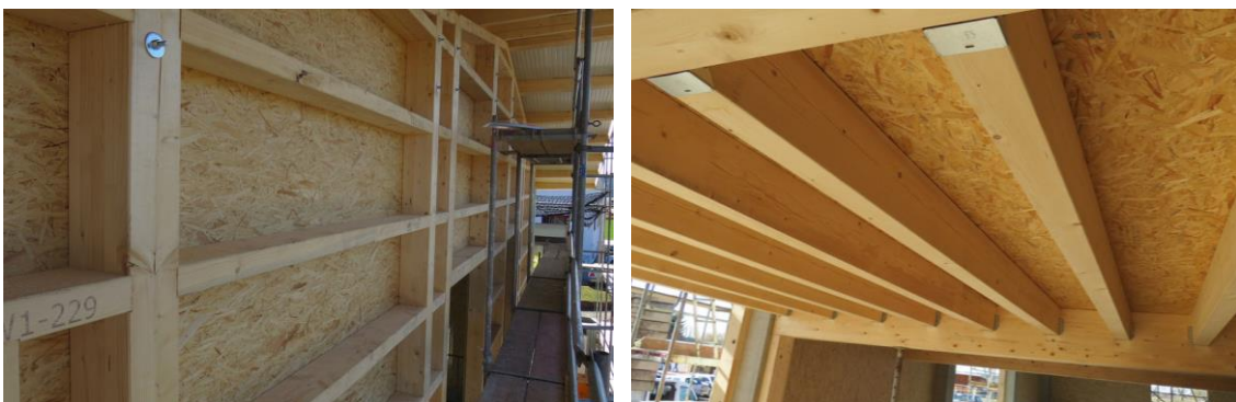
Luftdichte Innenbeplankung der Wände (links) und Deckenbeplankung mit SWISS KRONO OSB (Copyright: Holzbau Benjamin Roller | Fotos: SWISS KRONO GmbH)
