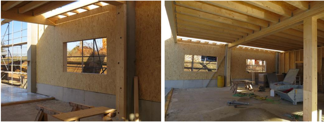
Sichtbar bleibende Seitenwände aus SWISS KRONO OSB bright mit Fensterausschnitt (Copyright: Holzbau Benjamin Roller | Fotos: SWISS KRONO GmbH)
