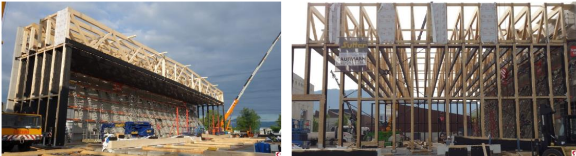
Tragwerkskonstruktion aus Holz mit hohen Ansprüchen an die Statik: Die Hallen entstehen: 66 Meter Spannweite ohne Stützen (Bildnachweis: Messe Dornbirn GmbH)
