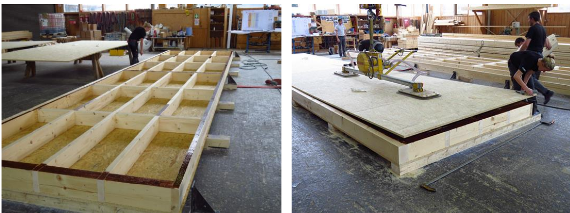
Vorfertigung der Kastenelemente mit SWISS KRONO OSB/3 EN300 im Werk von Kaufmann Bausysteme (Bildnachweis: SWISS KRONO GmbH)
