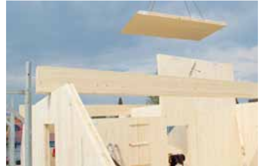
Schnelle Arbeitsfortschritt dank Massivholz-Bauweise.
