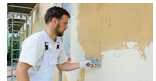
Beschichtung der Fassade mit dem neuen STEICO secure Putzsystem
