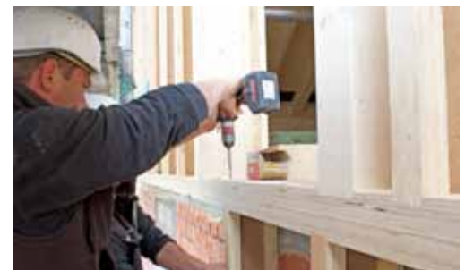
Fixierung der Stegträger von oben
