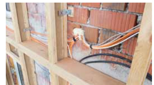
Leitungen an der Aussenseite innerhalb der Dämmschicht verlegt
