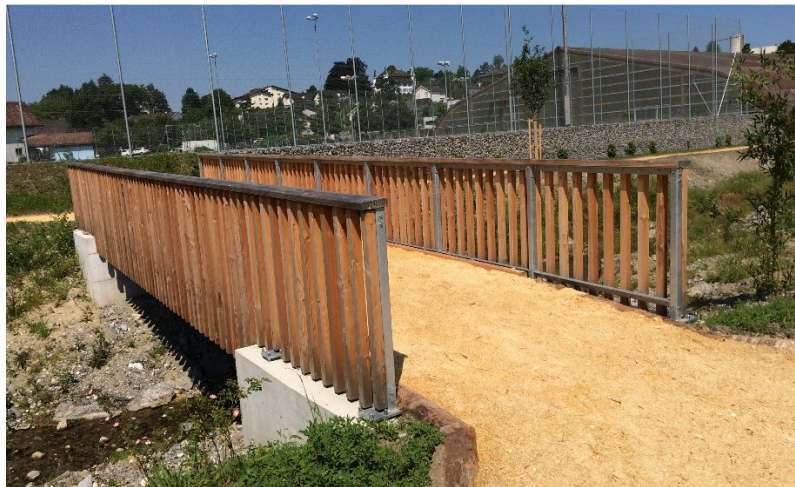
Bild 4: Dauerhafte Holzbrücke mit Hack Schnitzelbelag und Holzgeländer
