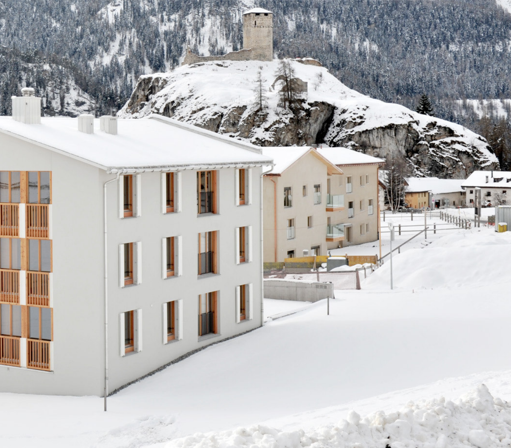
Das Gebäudeensemble prägt den nordöstlichen Ortseingang von Ardez. Typisch für Engadiner Dörfer ist die Staffelung der Gebäude. Im Erdgeschoss beherbergt die Chasa Marangun (l.) statt zweier Wohnungen den Zugang und die Garage für beide Gebäude, was eine direkte Anbindung an den öffentlichen Raum ermöglicht.
