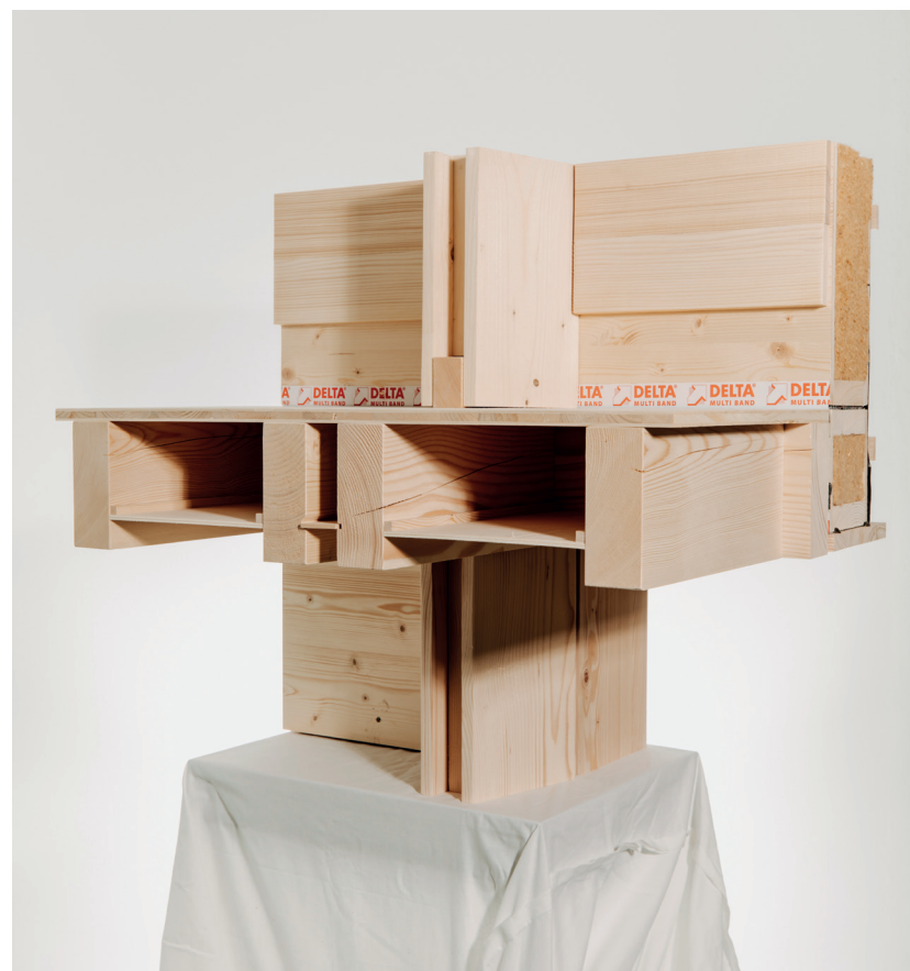
Mockup des Verbindungsknoten Decke-Wandanschluss
